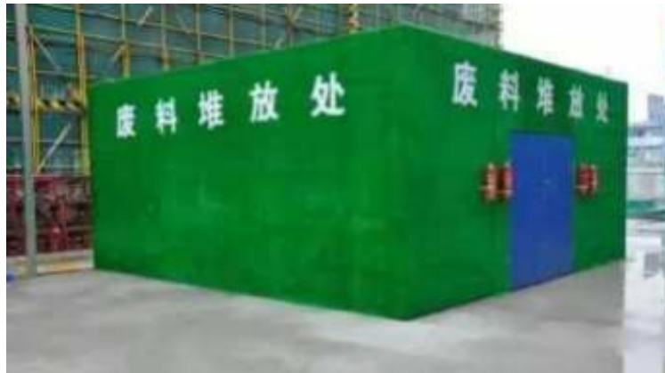
图3: 大厦废料堆放处
