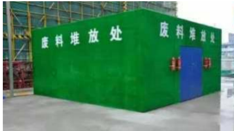
图3: 大厦废料堆放处
