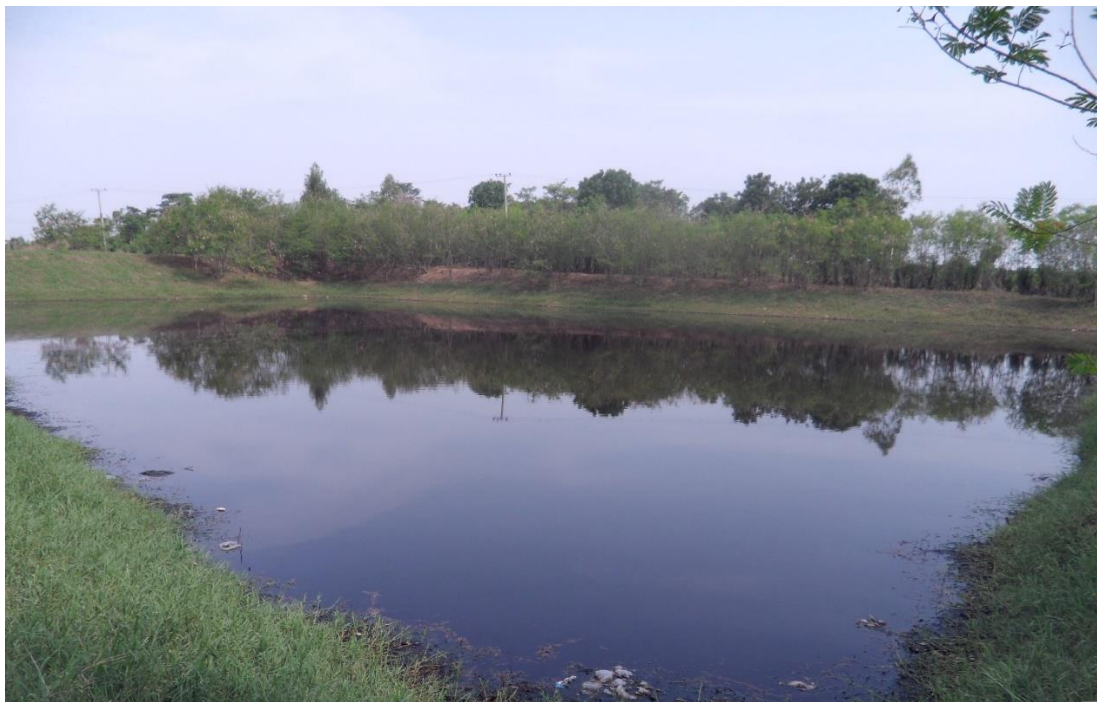
ภาพที่ 4: ระบบบำบัดน้ำชะขยะแบบบ่อฝังของสถานที่กำจัดขยะเทศบาลนครขอนแก่น
