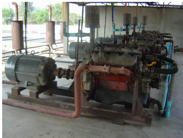
ภาพที่ 1 เครื่องยนต์ดัดแปลงเพื่อใช้ก๊าซชีวภาพเป็นเชื้อเพลิงที่ใช้ในโรงเลี้ยงสุกร
